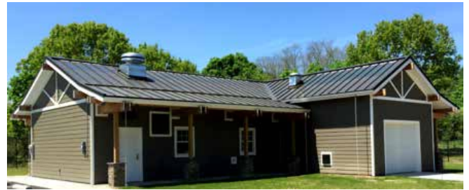
金属屋根への貼付け
