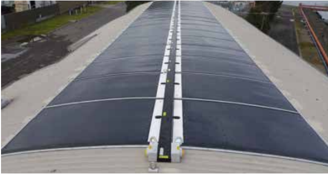
金属屋根への貼付け
