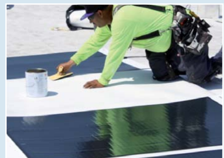
Limpia y Prepara el TPO
